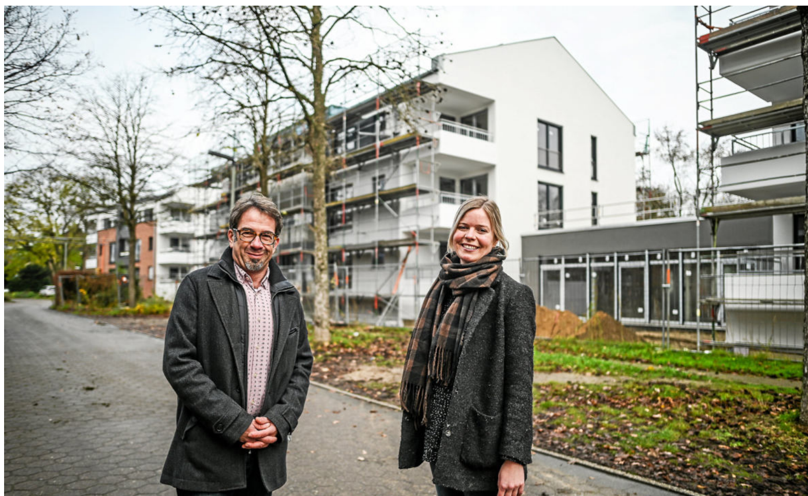
Guido Matzken und Jessica Tepass vor dem Gebäude, in dem zwölf Wohnungen zu vergeben sind. Im Hintergrund ist der Gemeinschaftsraum zu erkennen, der zwei Gebäude miteinander verbindet.
