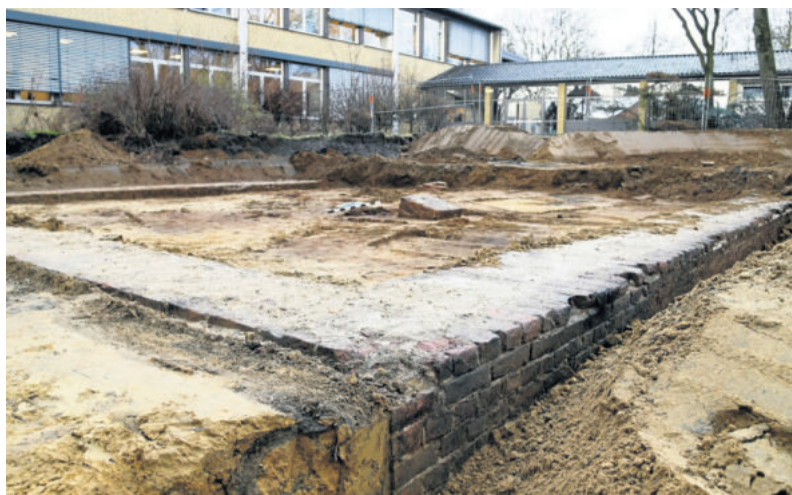
Diese Mauern bildeten wahrscheinlich das Fundament der mutmaßlichen Mannschaftsbadeanstalt. FOTO: MARKUS JOOSTEN / FUNKE FOTO SERVICES
