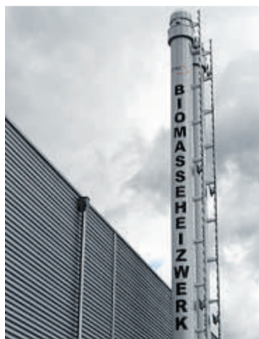
Die Anlage wurde vor zwei Jahren offiziell eröffnet.
