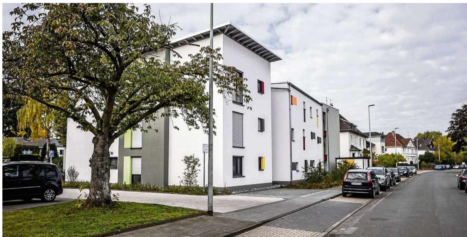
An der Helenenstraße hat die Wohnbau zwei neue Gebäude errichtet.
